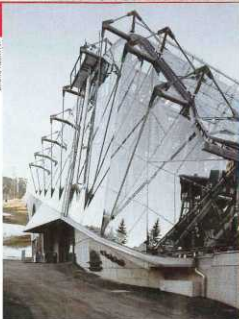
Galzigbahn-Talstation St. Anton am Arlberg Architekt: Georg Driendl, Driendl-Architects, Wien
