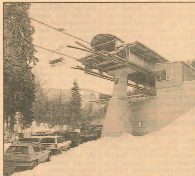
Dynamik einer Durchgangsstation: Liftbenützer fahren in eine Röhre, die weit über die Hangkante hinausragt.
